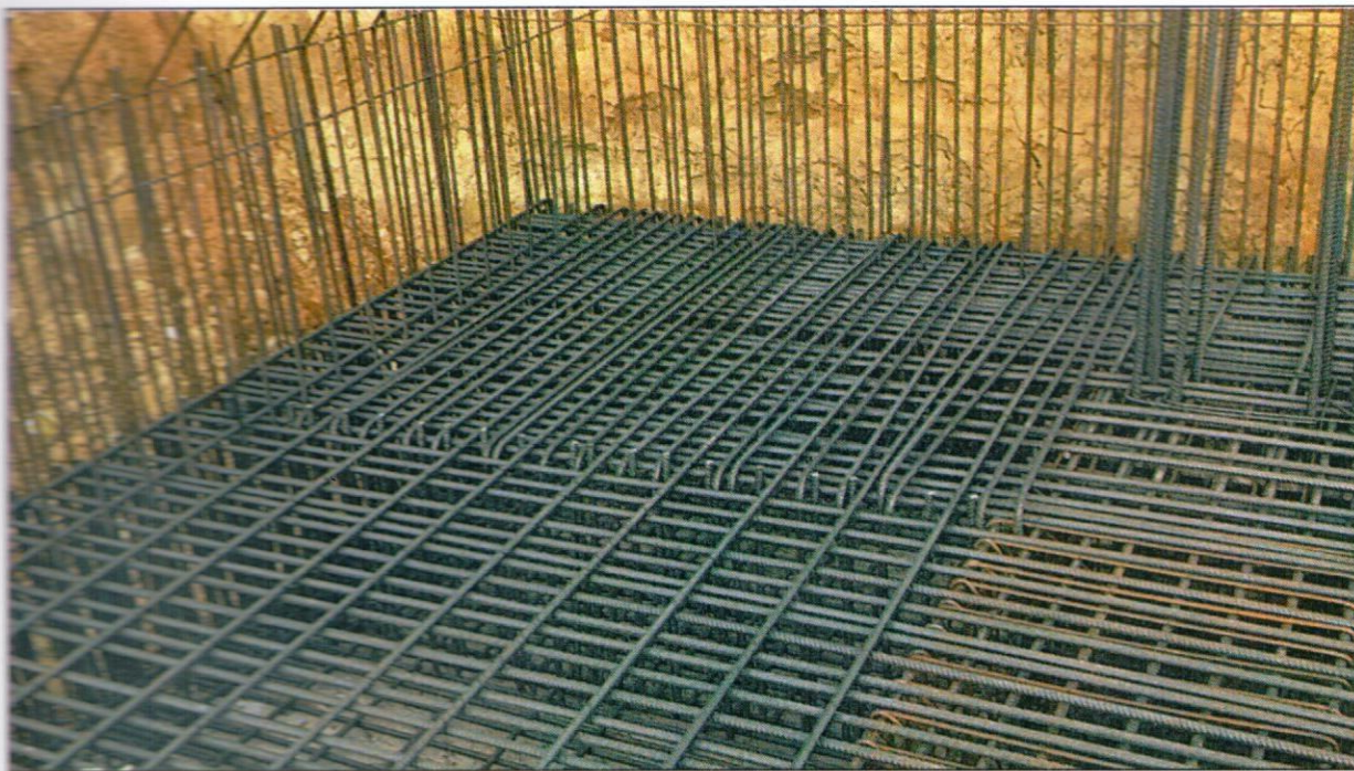
5- Angolo pilastro 29: ferri attesa e raffittimento per fondazione muro
