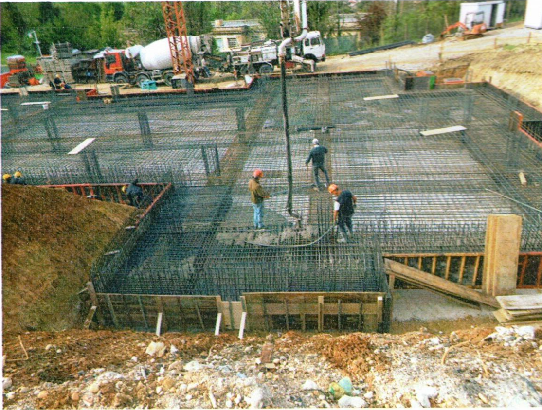
11- Panoramica allineamento pilastri 30-2 e 16-3 (Fili fissi 5 e 6)
