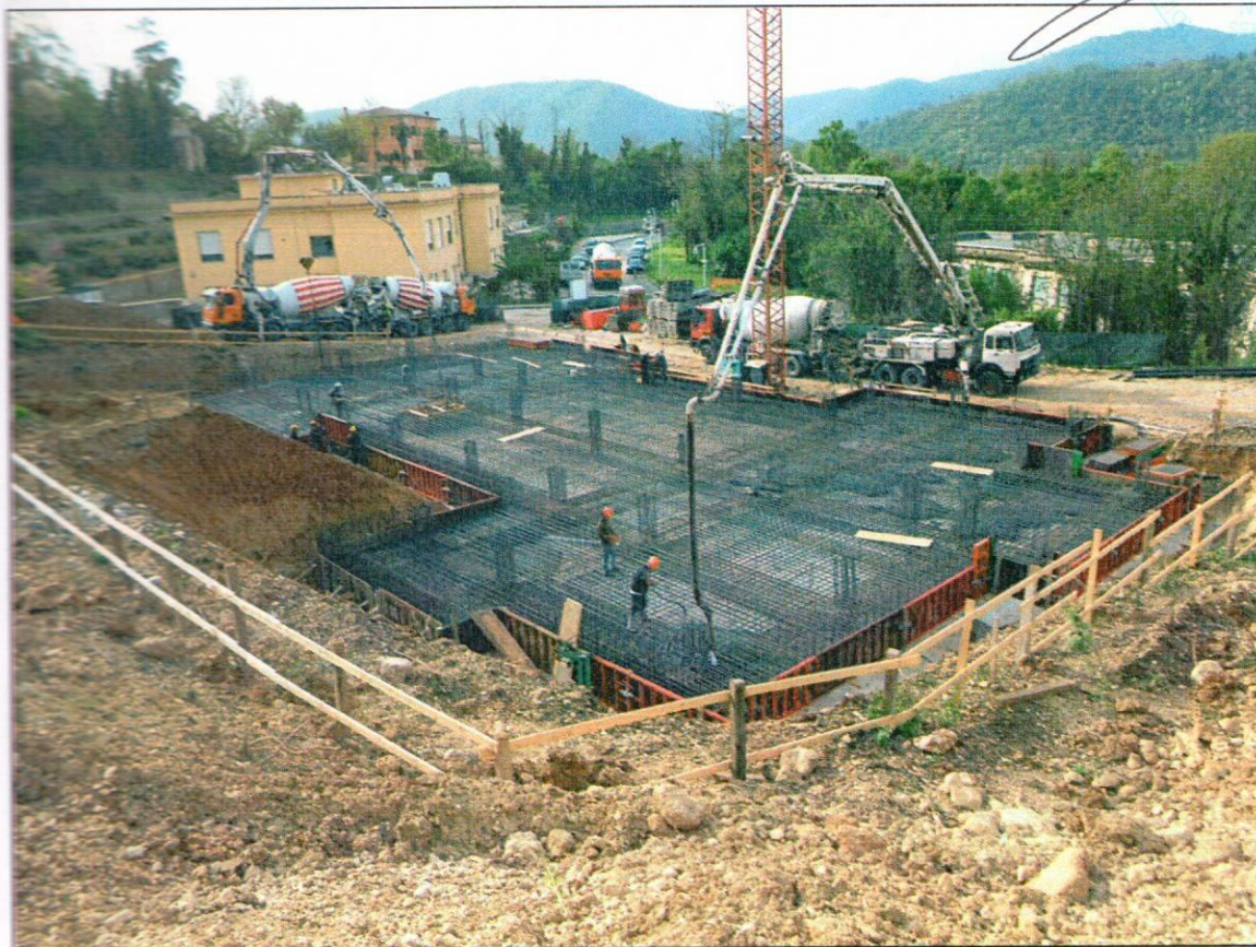
4- Panoramica da nord-ovest solettone fondazione
