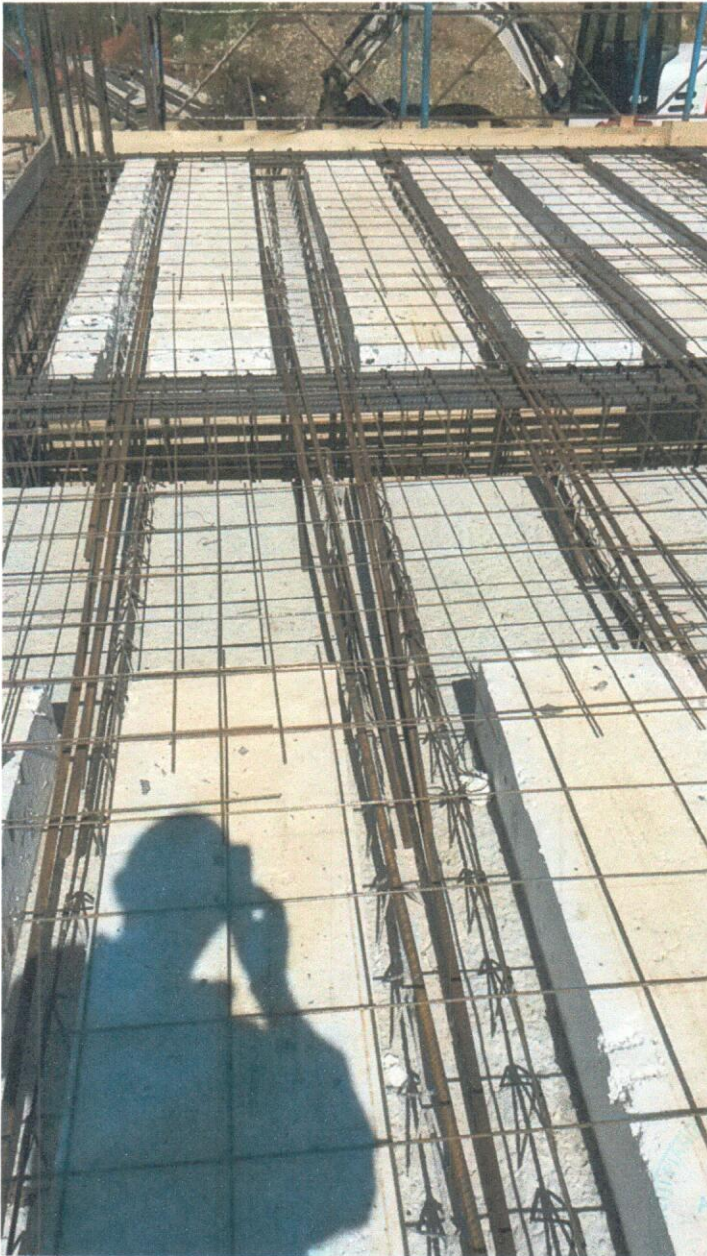
Armatura integrativa superiore tipo delle lastre Predalles
