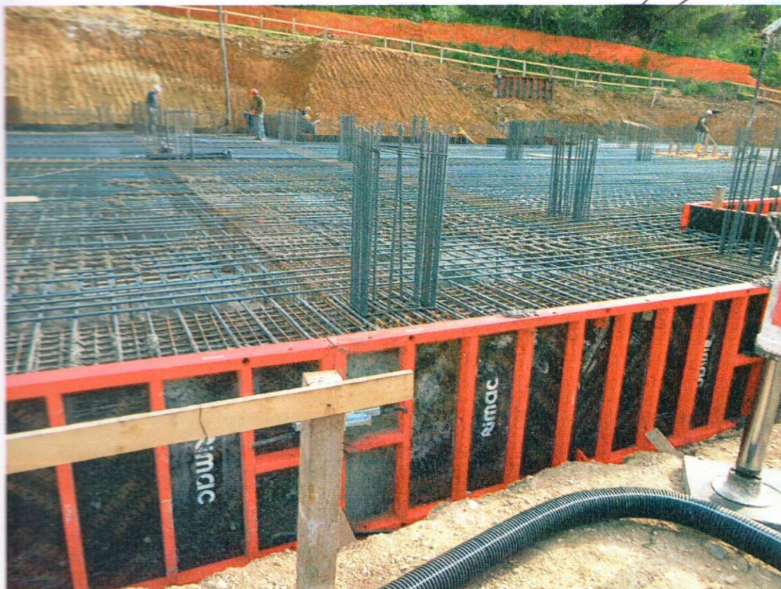
6- Allineamento pilastri 2-30 (filo fisso 5) e trave fondazione
