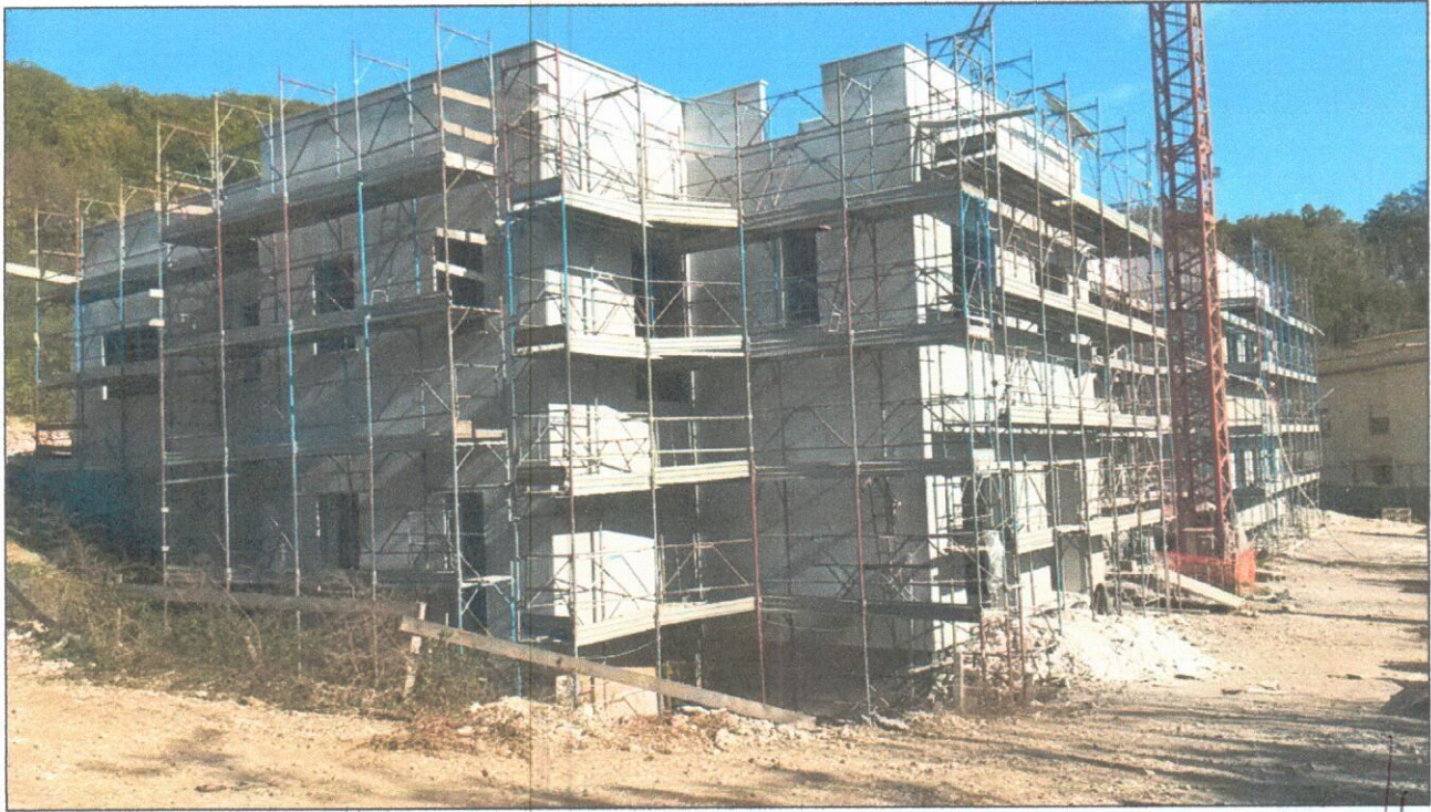
Foto 1 – Vista stato esterno edificio
