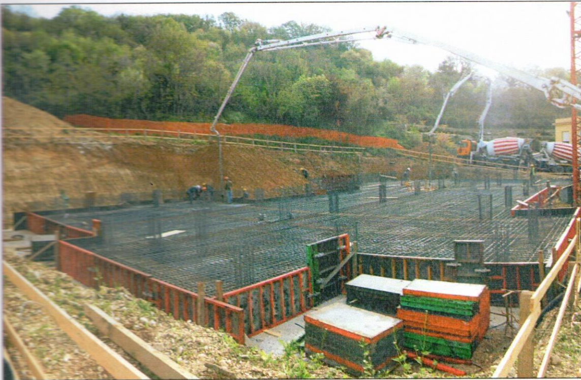
3- Panoramica da sud ovest solettone fondazione
