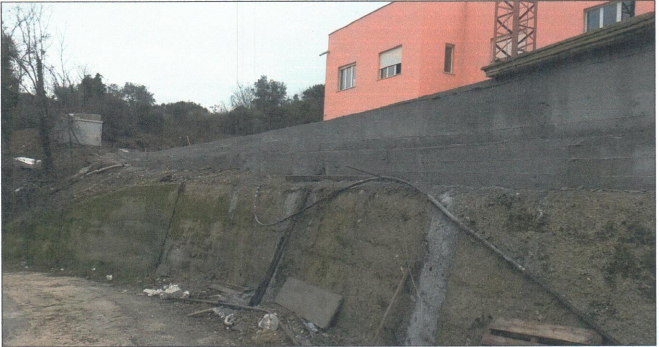
Foto 1 – Muro recinzione a valle
