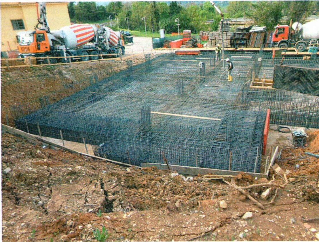
12- Panoramica allineamento pilastri 11-8 e 37-9 (Fili fissi 9 e 10)
