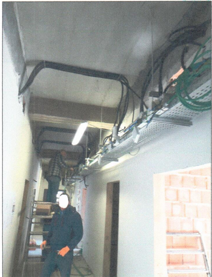
Foto 2 – Vista dorsale p.t. con cavidotti e cavi + intonaco interno
