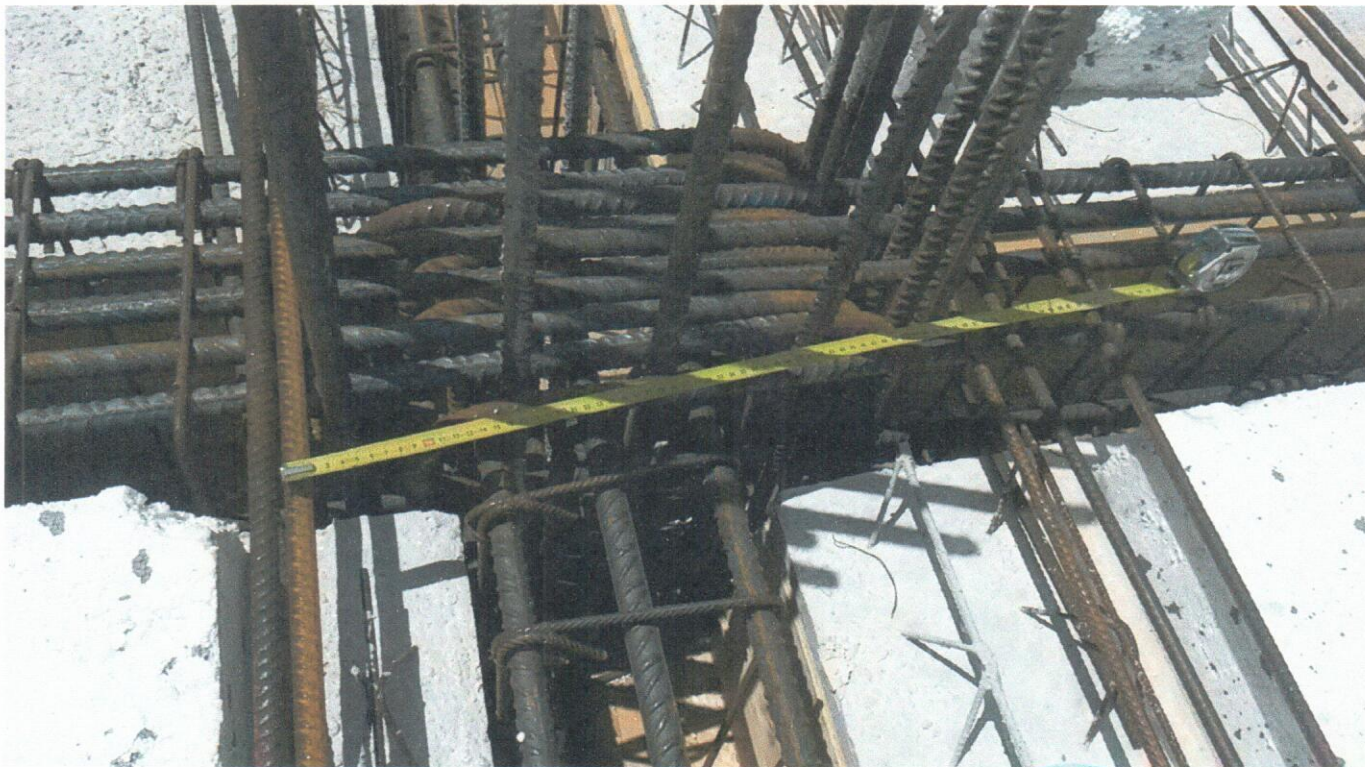
Vista da est armatura pilastro 19
